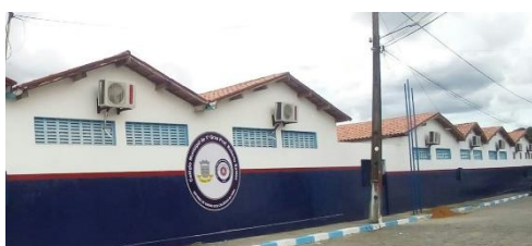
Imagem 2 – Estrutura da escola em 2020
