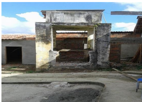
Imagem 1 – Estrutura da escola em 2018
